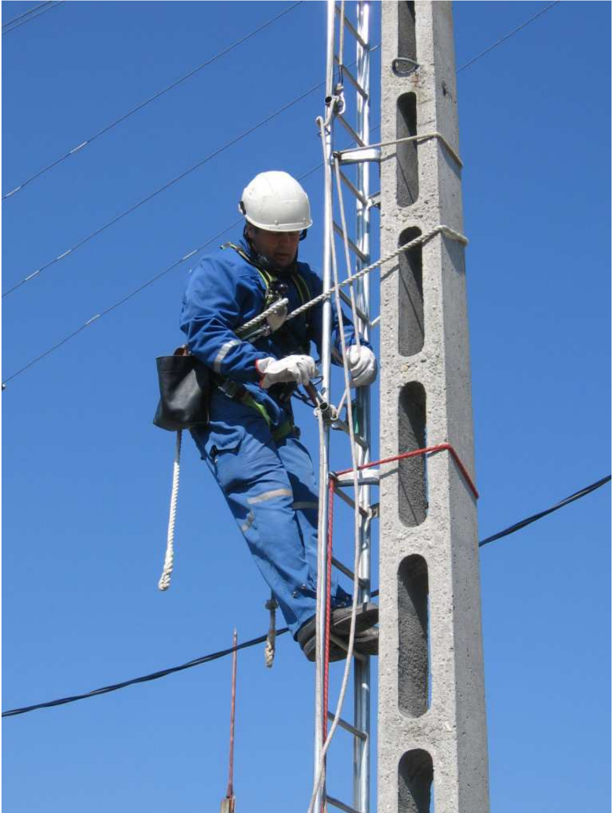
Betonoszlopra mászásnál használt biztonságos védőeszközök
