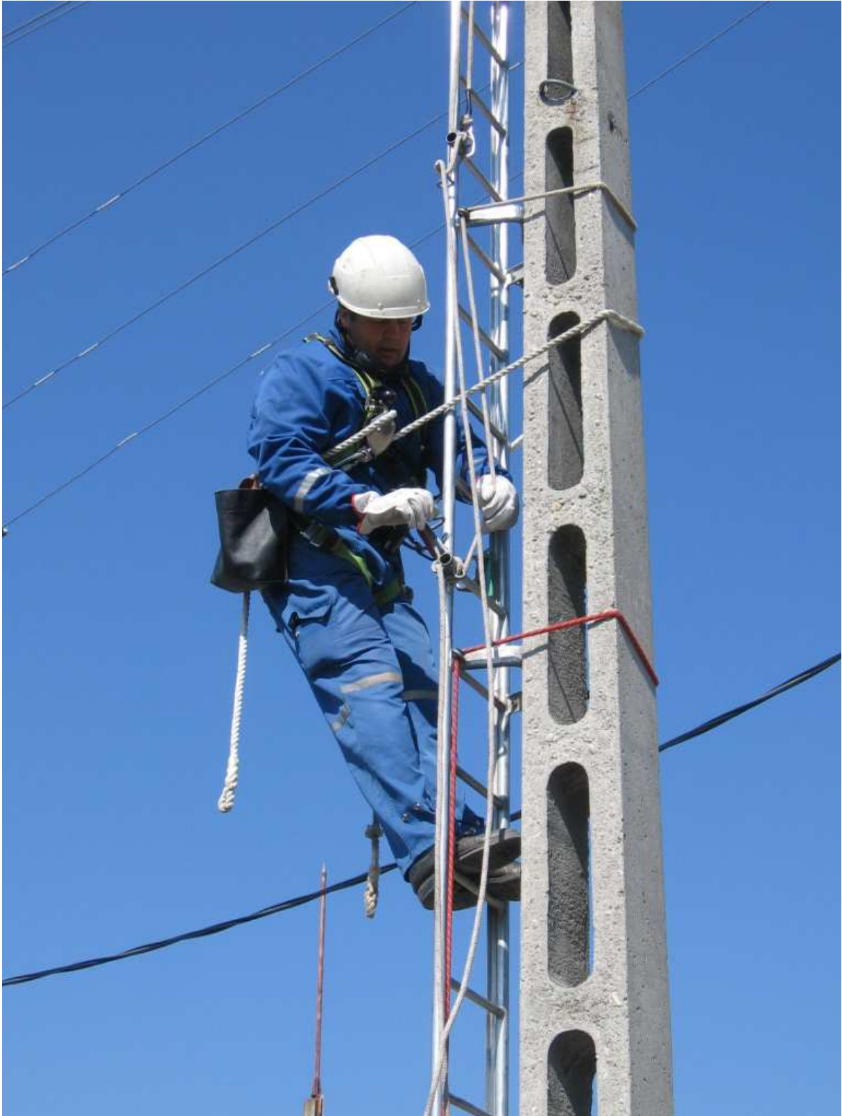
Betonoszlopra mászásnál használt biztonságos védőeszközök
