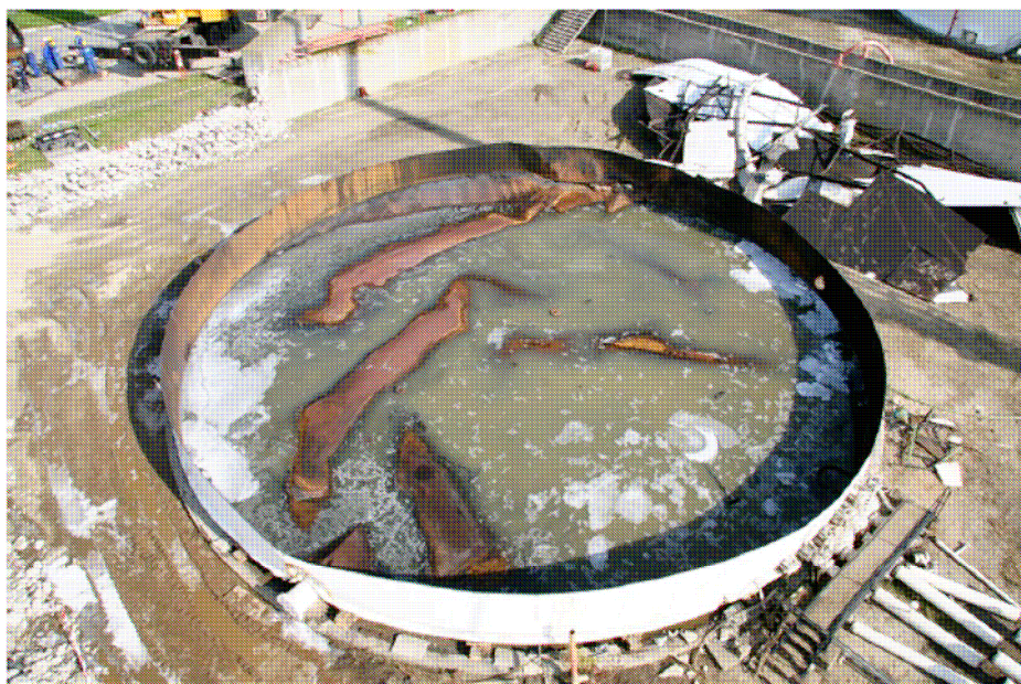
A képet a tartály megrongálódott oldal falának eltávolítása után készítették
